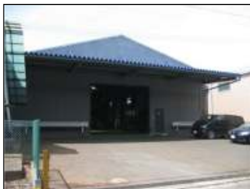
第二工場全景
